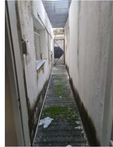
Entrada Corredor Recepção para fora
